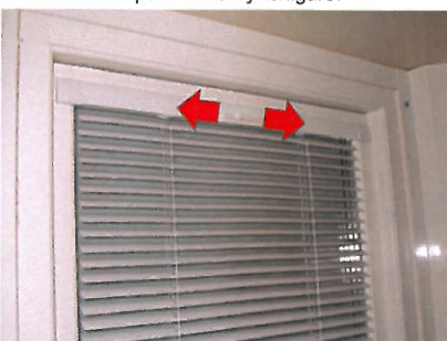
14 Lamellerna vinklas till önskat läge genom att föra reglaget till höger eller vänster.
