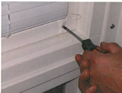
8. Skruva för hand fast de båda linfästena med de medföljande skruvarna.
