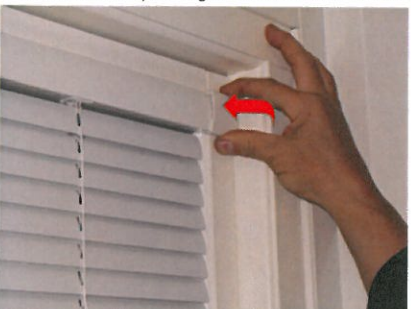
13 Täckåporna monteras över persiennfästena. Vid behov justeras underlisten så att den ligger vågrät.
