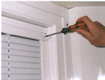
5. Skruva för hand fast persiennen/plissén med de medföljande skruvarna.
