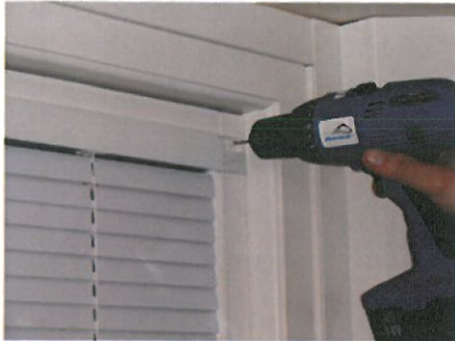
4. Tryck fast persiennen/plissén mot glasöppningens överkant. Förborra för två skruvar i varje sida enl. bild.
