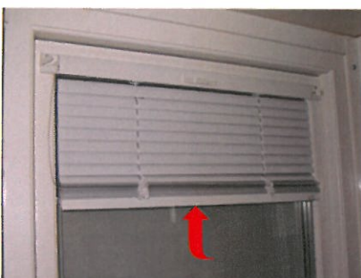
11 Kontrollera att persiennen/plissén stannar i önskat läge när den förs upp och/eller nedåt. Vid behov spänns linan ytterligare.
