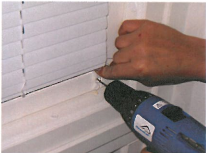
7. Förborra för en skruv i varje fäste.
